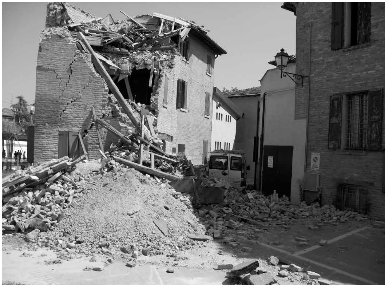
S. Felice sul Panaro - Danni del terremoto
