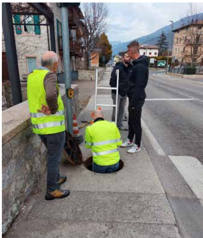
Le immagini del sopralluogo alla roggia di Stravino con il Dirigente del servizio Gestione Strade PAT
