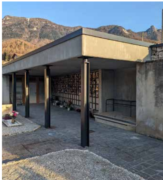
Un'immagine dei lavori per la sistemazione della camera mortuaria Presso il cimitero di Vigo Cavedine.
